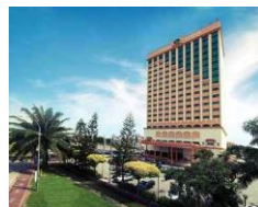
Sunway Hotel Seberang Jaya
