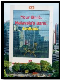
Bangunan AmBank Group
